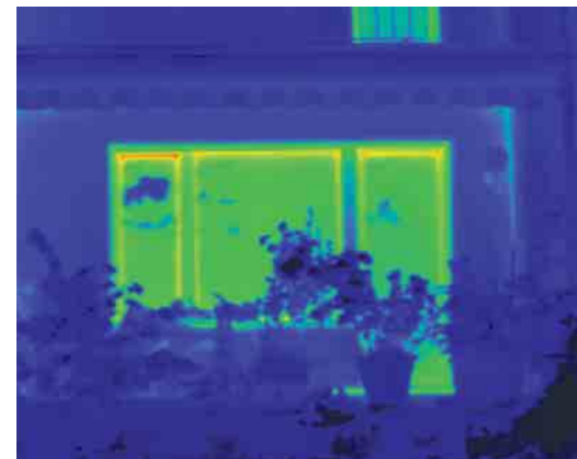
Nach dem sorgfältigen Einbau neuer Fenster aus dem Profilsystem Schüco Corona CT 70 Rondo beweist die Thermografie den hohen energetischen Nutzen der Investition. Der ursprüngliche Energieverlust wird nahezu vollständig vermieden.
