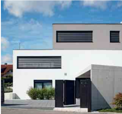
Fenster sind dominante Gestaltungselemente.
